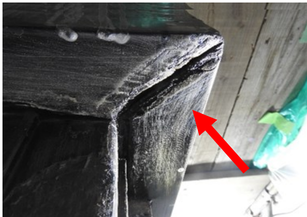
▲ 木材の隙間も埋めていきます
