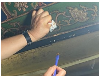
▲剥落止め作業の様子
