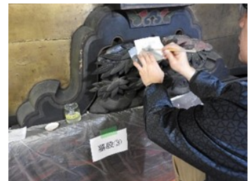
▲洗浄作業の様子
