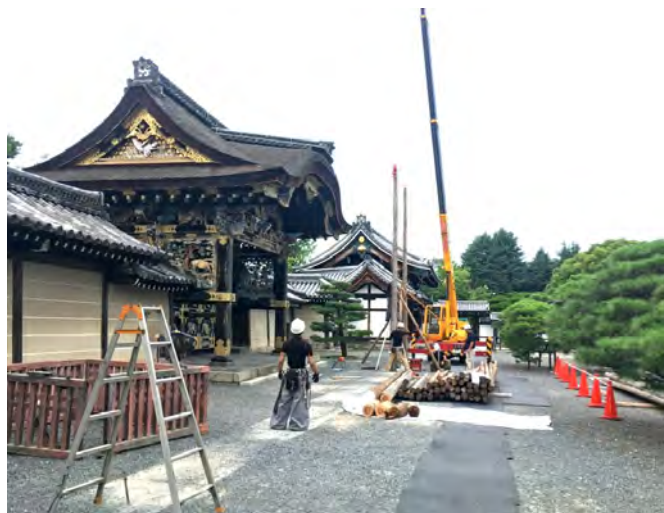
▲ 長い丸太はクレーンを用いて建てる
