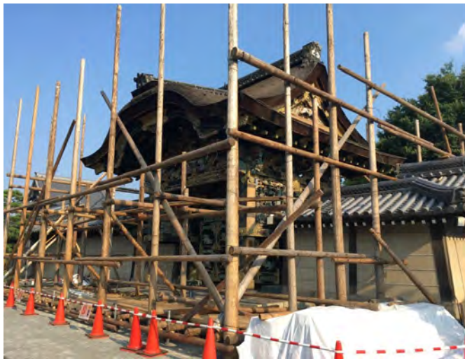
▲ 丸太での骨組み
