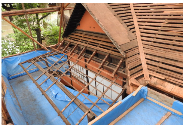
▲解体された憶昔屋根
