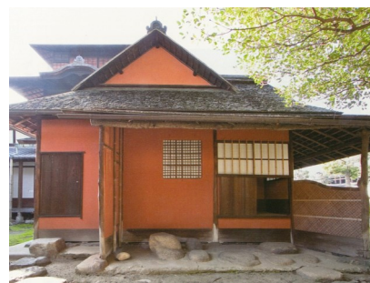
▲憶昔外観(修復前)
