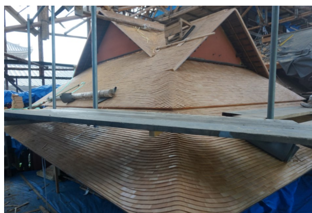
▲新しくこけらが葺かれた憶昔屋根
