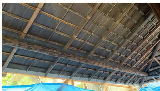
▲完成した庇の天井
